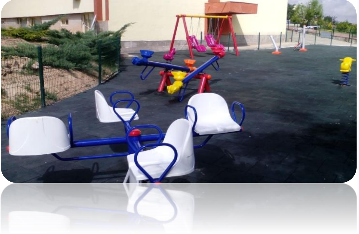
Kozaklı rehabilitasyon merkezine engelli parkı yapımı.
